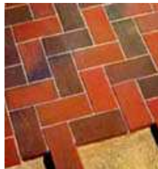
Укладка в елочку
