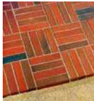
Модульная укладка дорожной брусчатки
