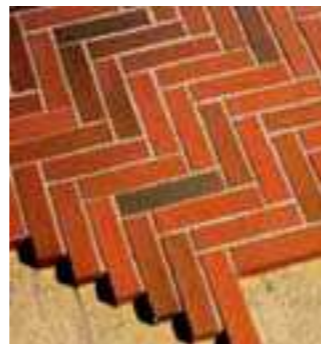
Укладка дорожной брусчатки в елочку
