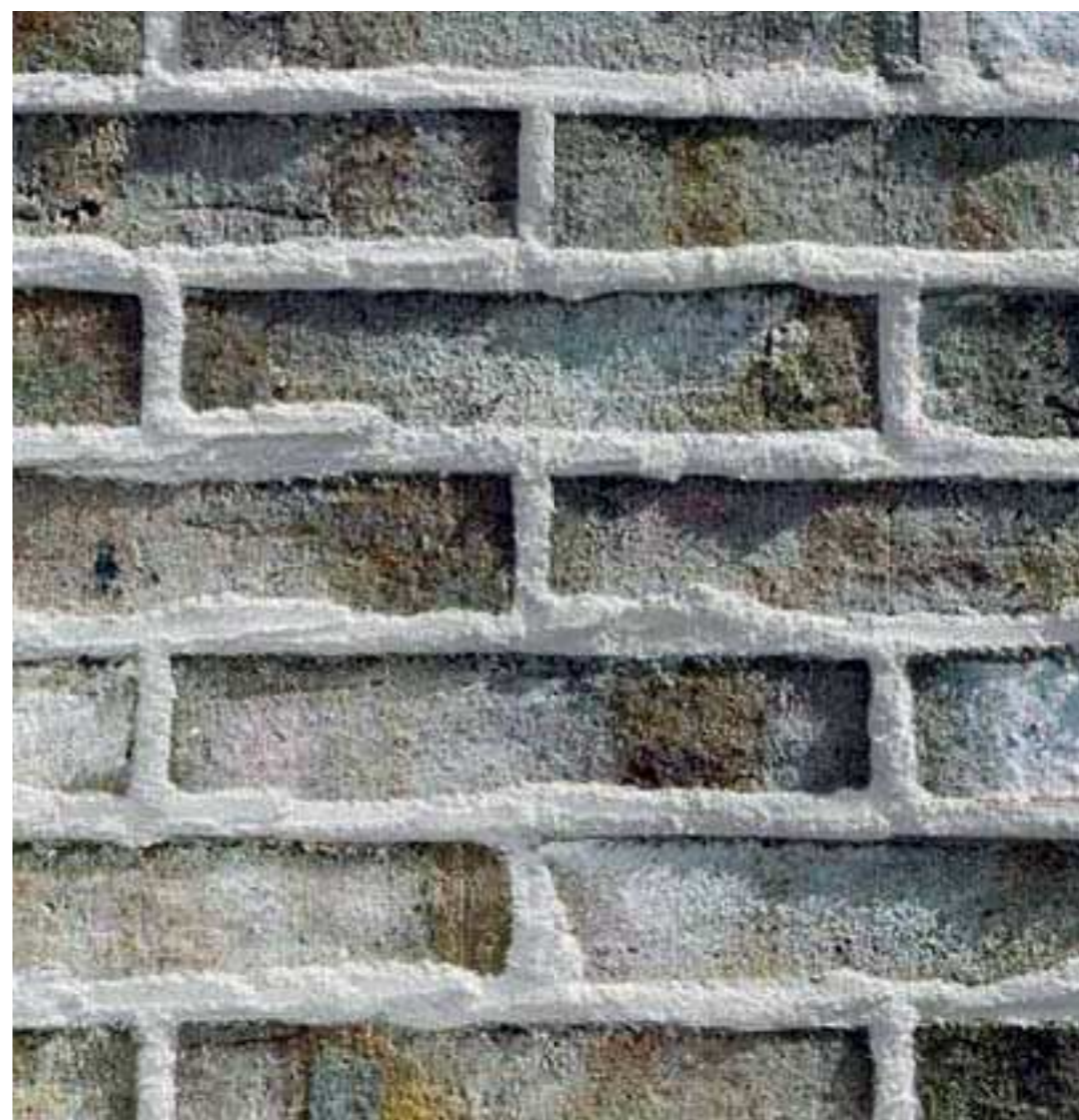
Выступающий шов подходит не для каждого камня. Но в данном случае с самобытным угольно-белым облицовочным кирпичом ручной формовки WIESMOOR DF это — чрезвычайно привлекательный вариант.
